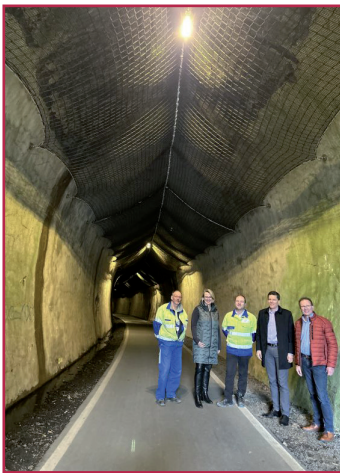
Dirk Klappert (Westnetz GmbH), Bürgermeisterin Nicole Reschke, Tim Kröning (Westnetz GmbH), I. Beigeordneter und Stadtkämmerer Julian Lütz und Achim Loos (Westenergie)
