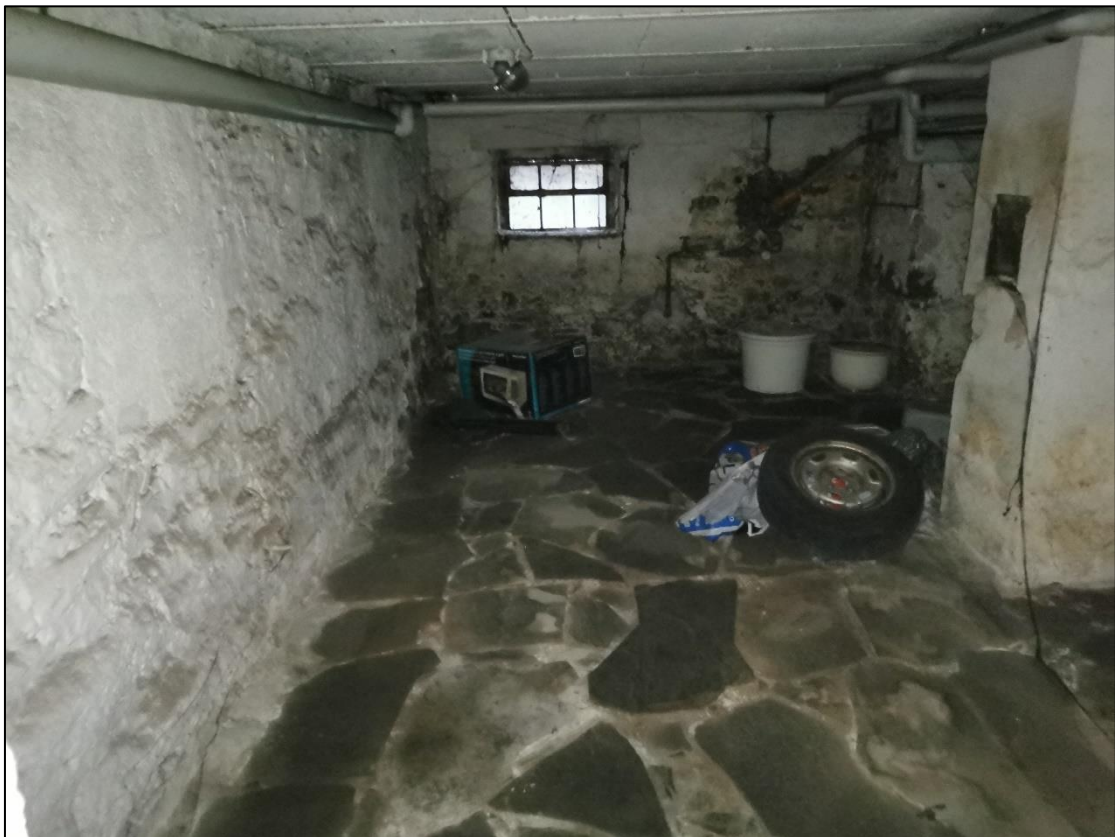
Abbildung 18: Kellerraum als Lagerraum, Haus Nr. 48
