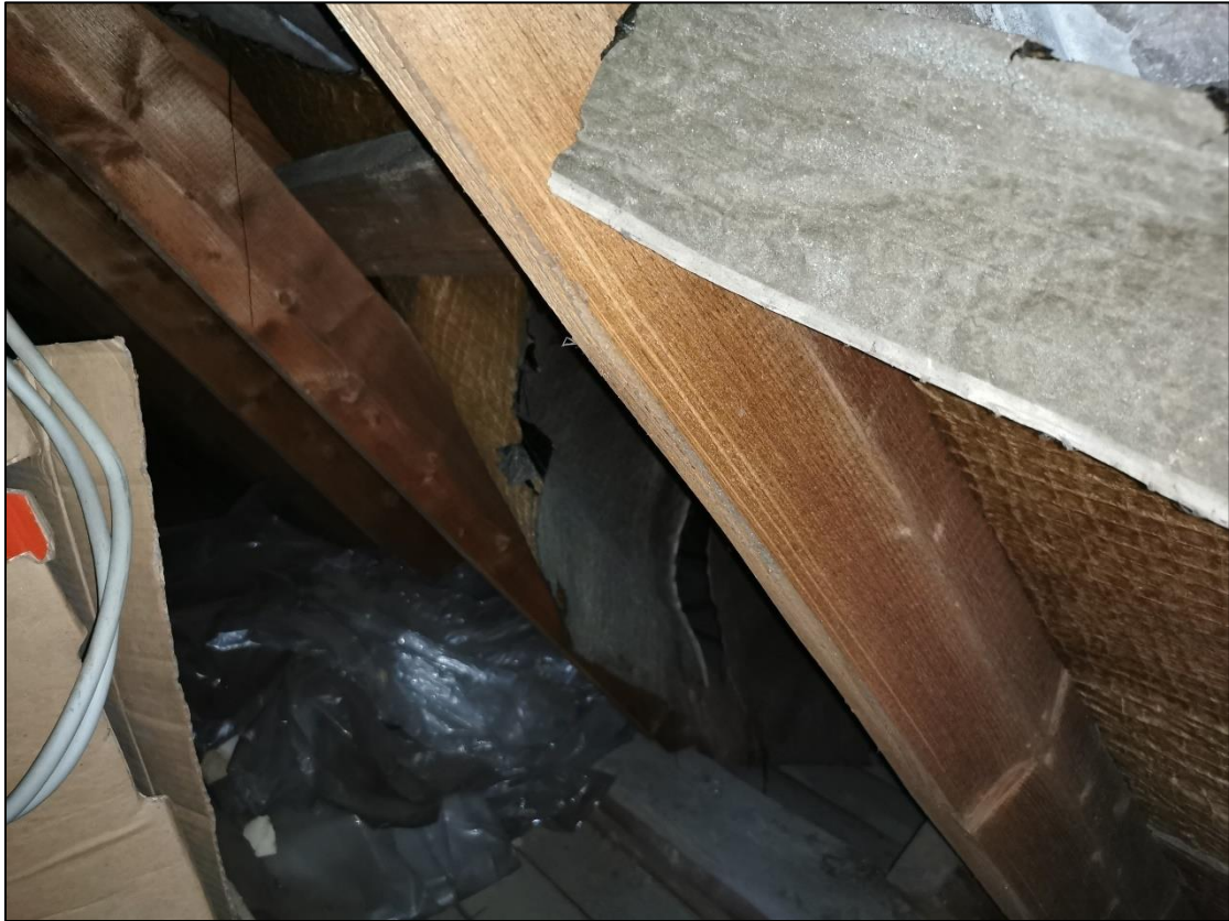
Abbildung 6: Dachboden seitlich, nördlicher Teil, Haus Nr. 46
