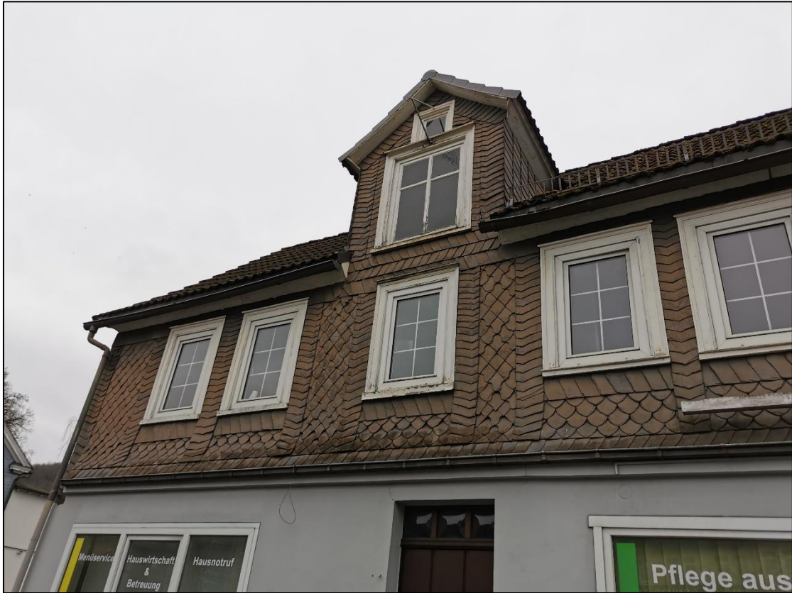
Abbildung 11: Straßenansicht Haus Nr. 48
