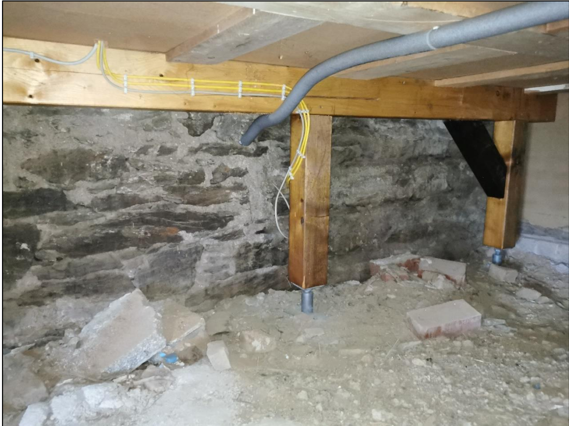
Abbildung 16: Gemauerte Kellerwand, Haus Nr. 48
