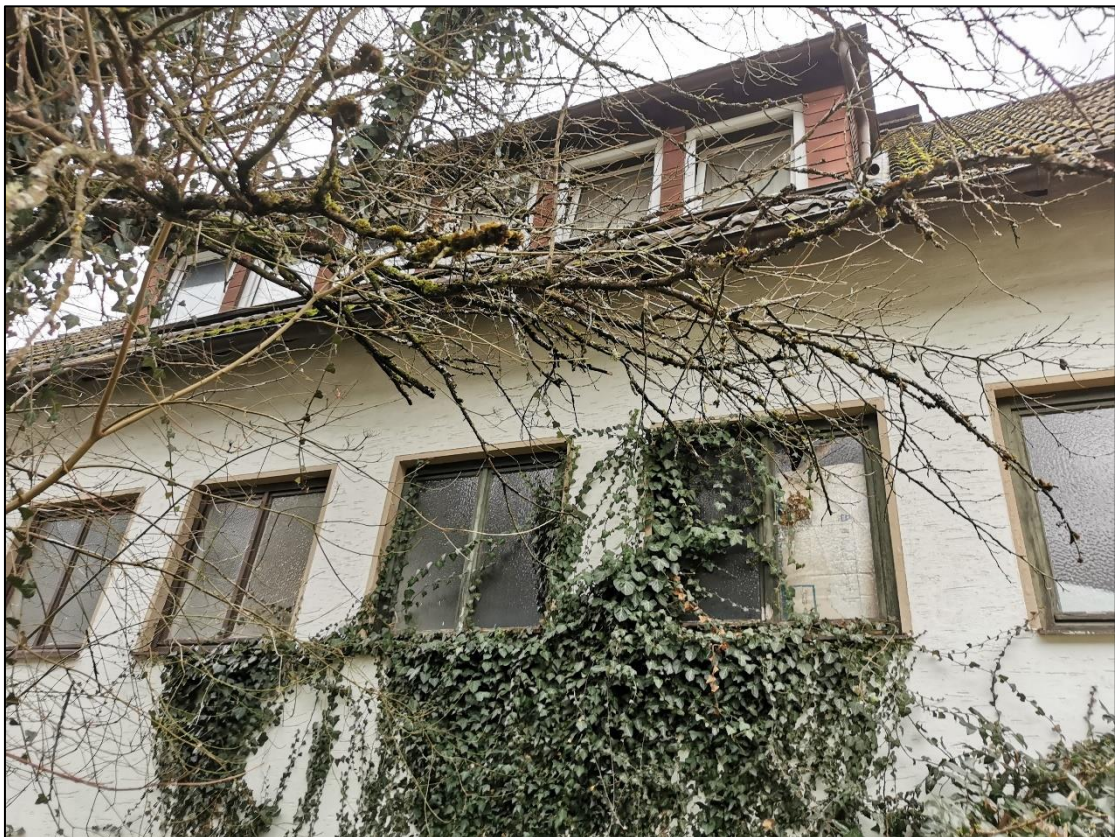
Abbildung 4: Rückwärtige Ansicht Haus Nr. 46
