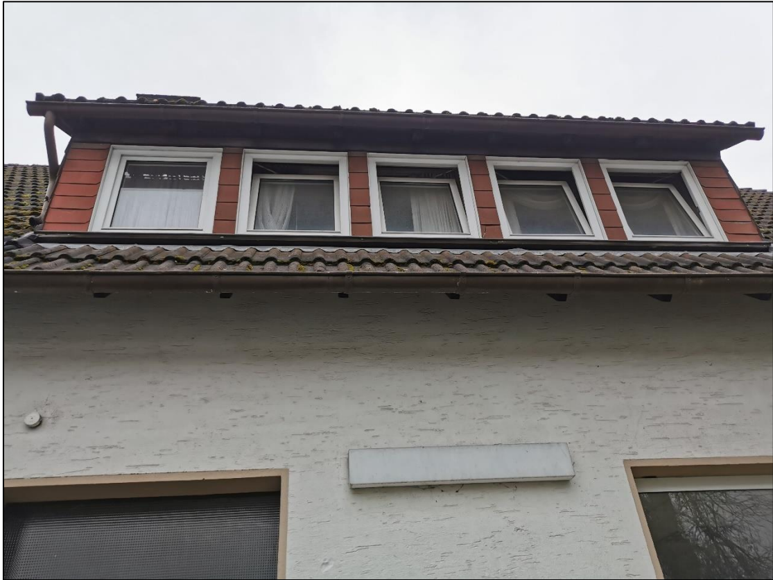
Abbildung 3: Straßenansicht Haus Nr. 46
