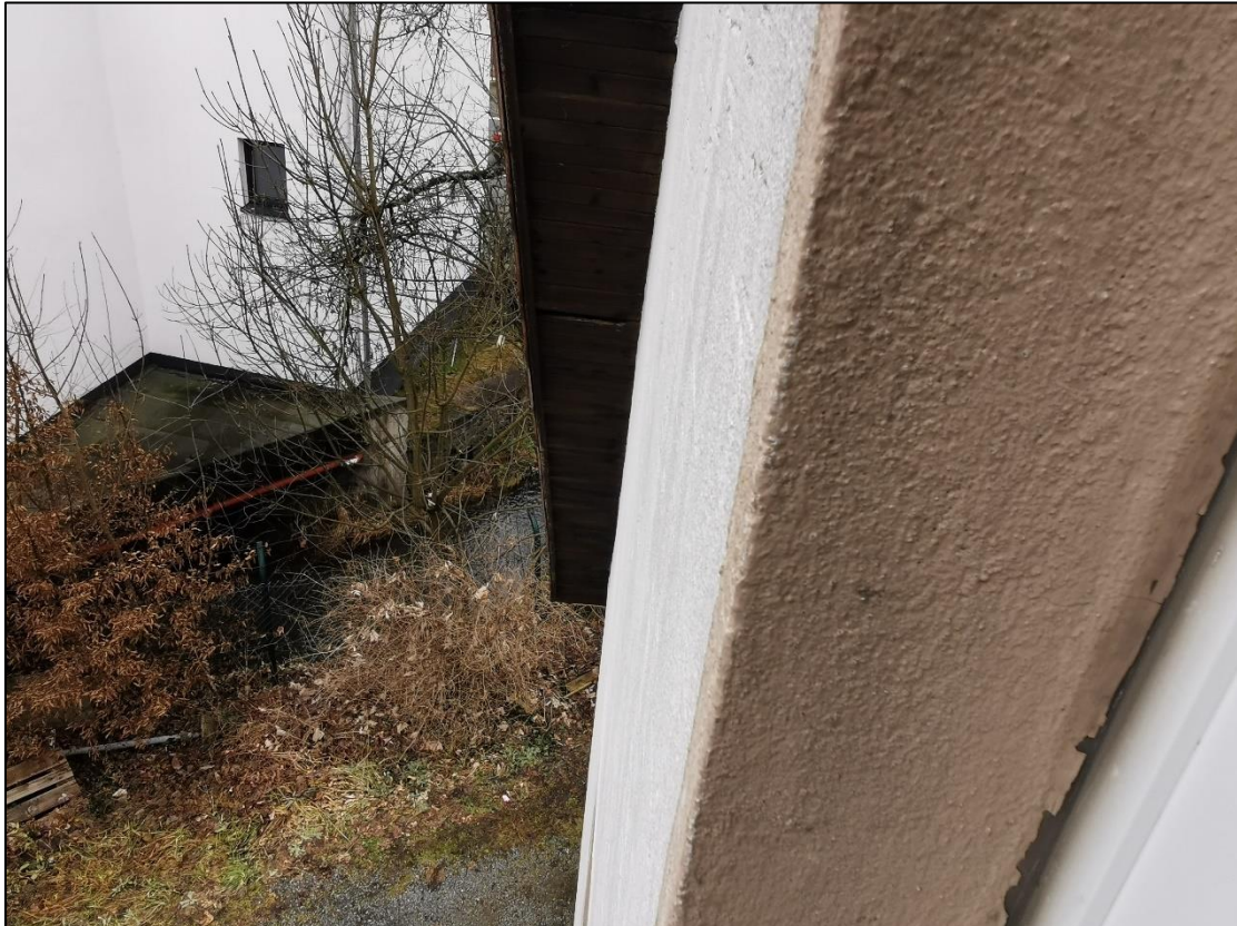
Abbildung 5: Dachbereich außen, Haus Nr. 46
