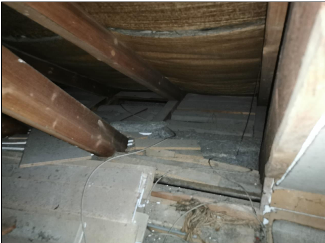
Abbildung 7: Dachboden seitlich, südlicher Teil, Haus Nr. 46
