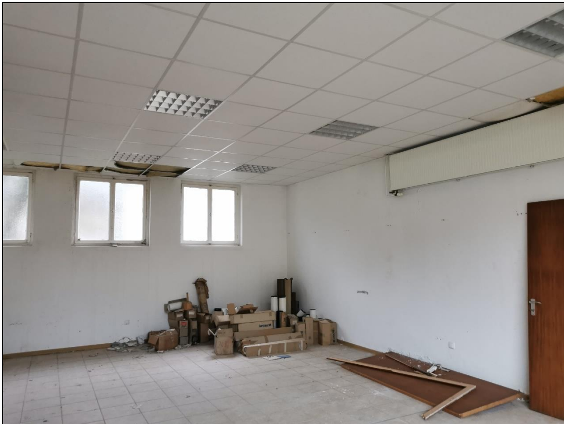
Abbildung 8: Lagerraum Erdgeschoss, Haus Nr. 46
